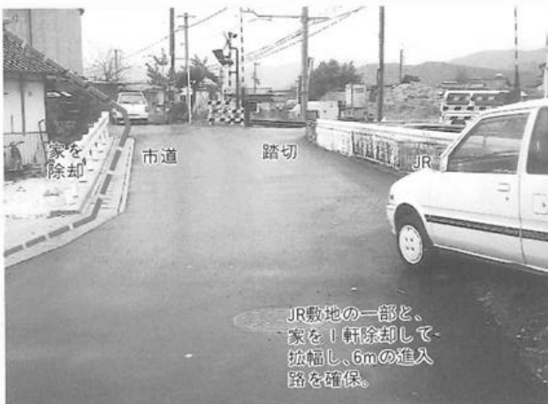
JRと協議して、拡幅できた進入路。住宅も1軒除却した。
