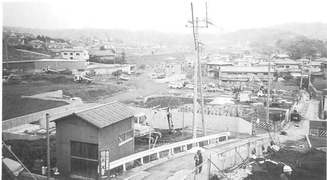
●造成工事の進む小田原市前川 土地区画整理事業地区
