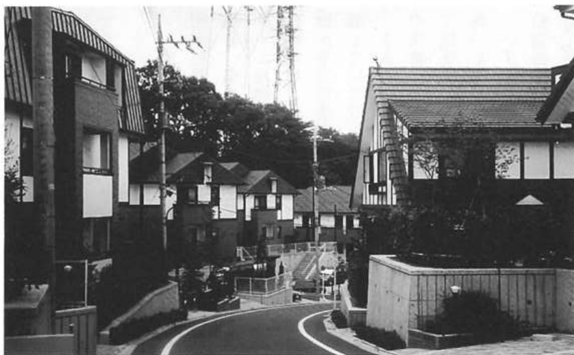
区画整理により賃貸住宅用地を集合換地し、ゆったりとした共有空間や生産緑地を抱え、独自の家並みを形成する戸建感覚の「しあわせ野」
