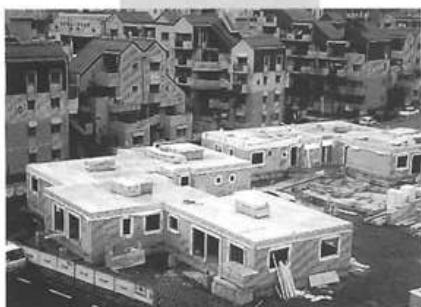
1階壁、2階床完了
