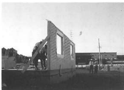
1階パネル建込み
