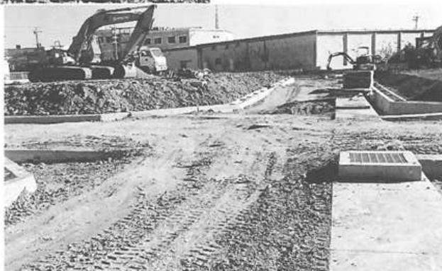
急ピッチで進む中小路農住組合の宅地造成工事
