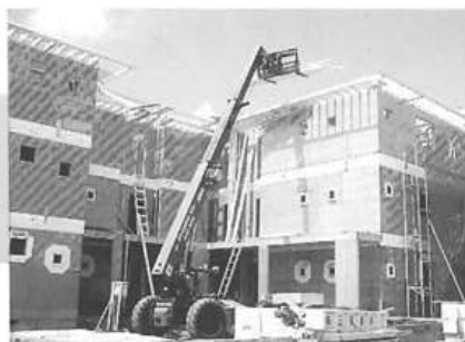
2階、3階完了、屋根荷上げ
