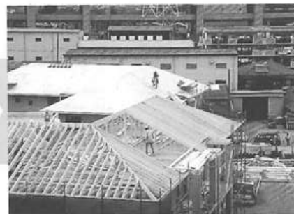
屋根、小屋組み(7月完了)
