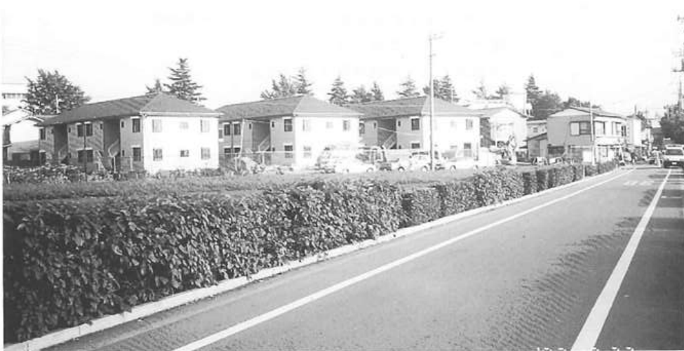
▲道沿いを生垣で修景された生産緑地と建設中のアパート群 (横浜市瀬谷区本郷地区)
