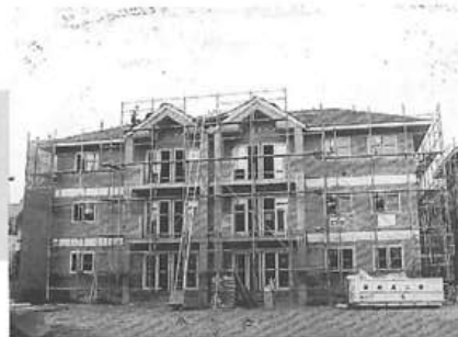
屋根、外壁仕上げ
