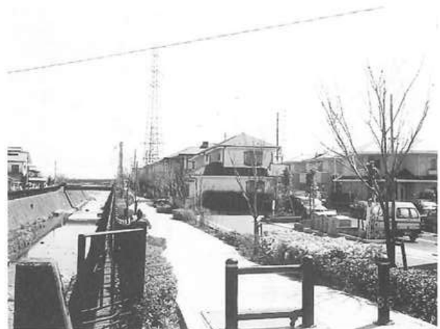
下河内地区住宅地の程久保川沿い入口付近
