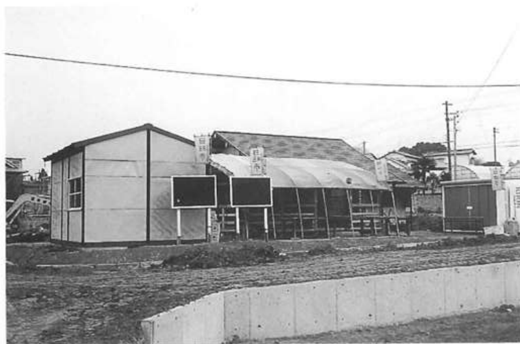
写真二 整備中の休憩所と広場
