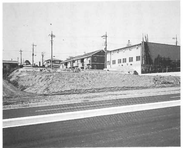
▲テナント建築前の道路整備状況
