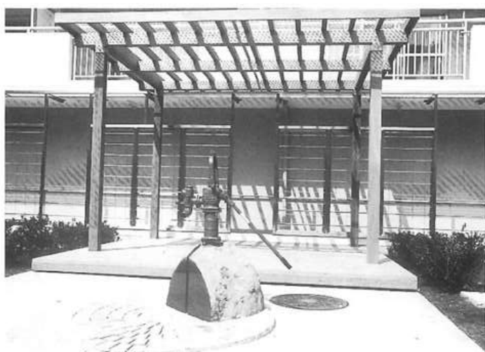
中庭の雨水利用手押しポンプ
