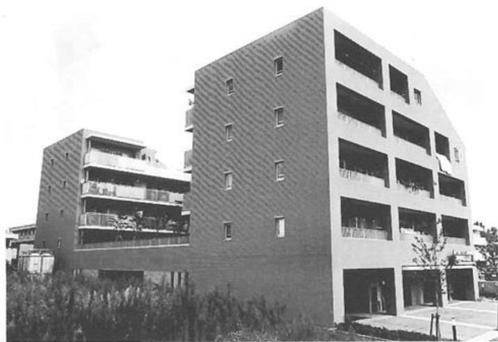
写真1 つくば方式1号 周辺には都市農地が点在する区画整理地。1階は地主所有の貸店舗、2階以上が間取りが自由設計できるスケルトン定借住宅として入居者の持ち家になっている。
