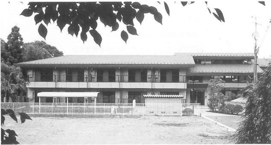
写真1 シャロームつきみ野の全景（竣工時）
