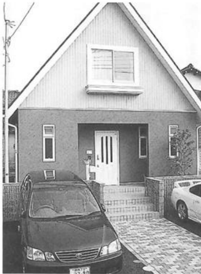
事例4の「まほーむ」戸建て賃貸住宅
