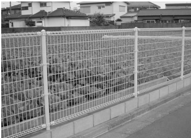
土砂流出の防止、ゴミ投棄を防止するための 土留め・フェンス整備
