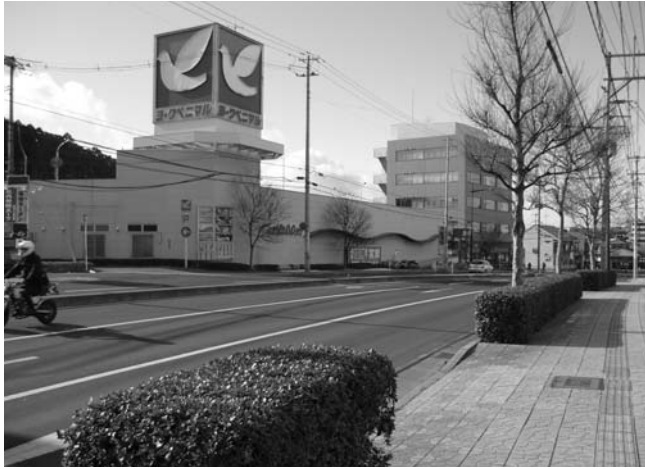
写真4 共同利用街区の景観と建物
