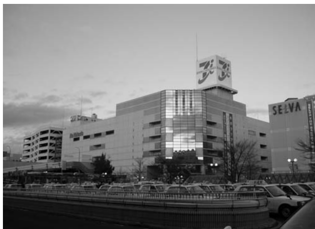
写真3 共同利用街区の景観と建物
