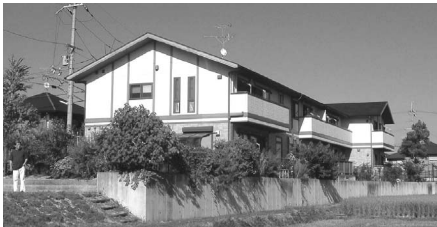
写真1 下の田んぼ側から見たコミュニティハウスの全貌
