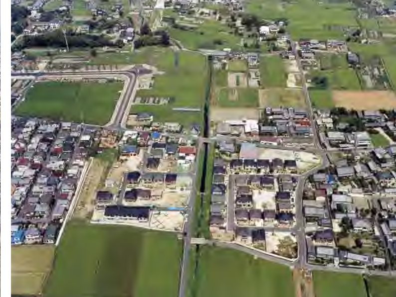
整理後の空撮
