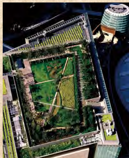
屋上庭園全景
