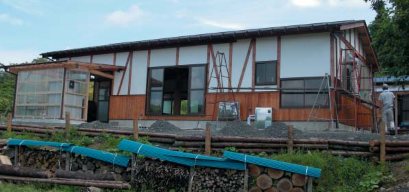
家づくり体験塾による井上さん宅の工事現場
