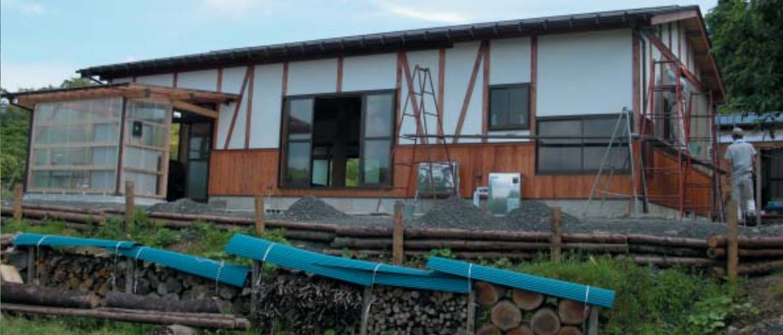
家づくり体験塾による井上さん宅の工事現場
