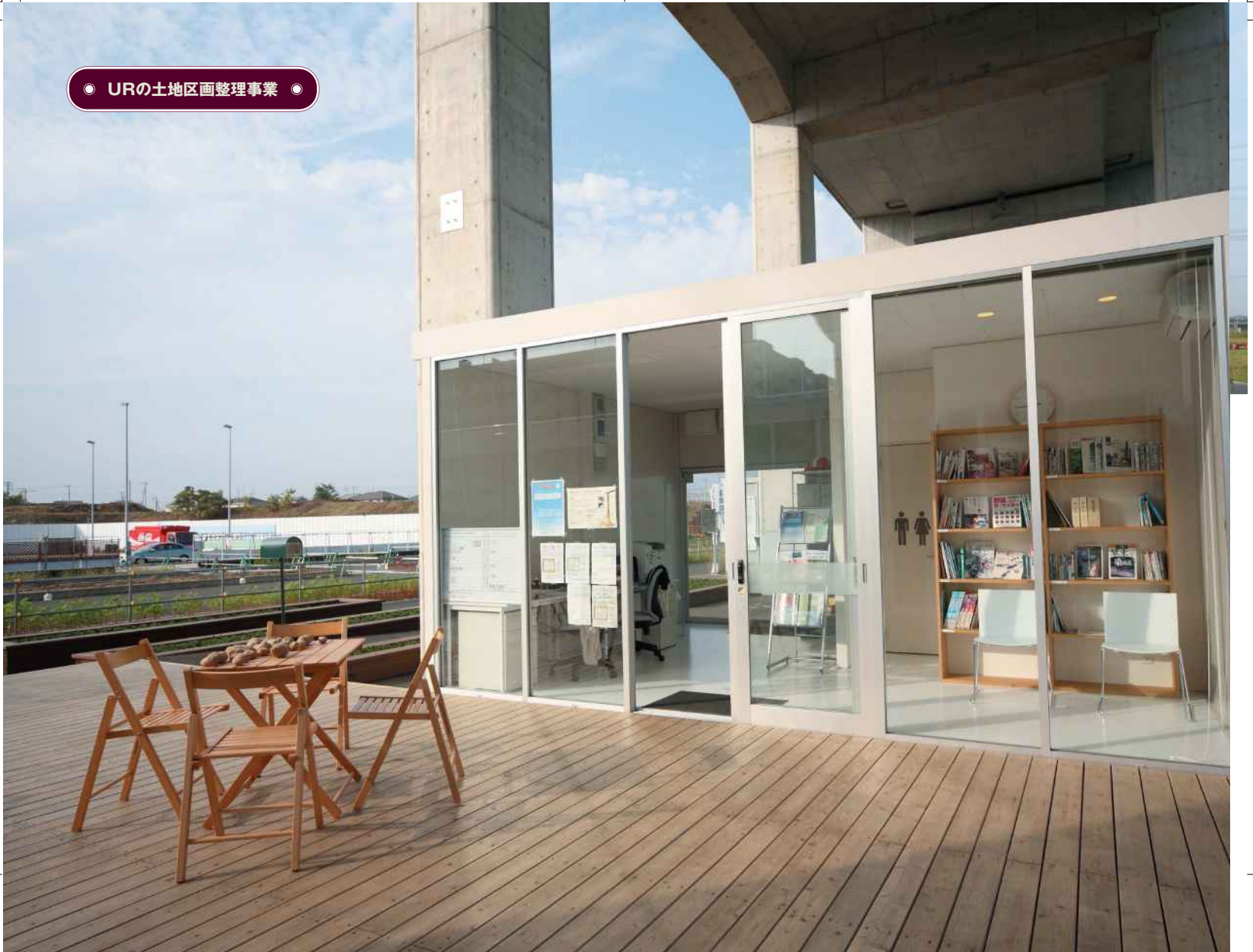
JR柏たなか駅高架下につくられた環境コンビニステーション
