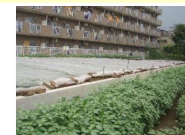
土砂流出防止の土留め
