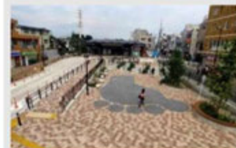
世田谷代田駅前広場の足あとシンボルに透 水性舗装のほか、一部範囲に雨水貯留型ブ ロックを採用
